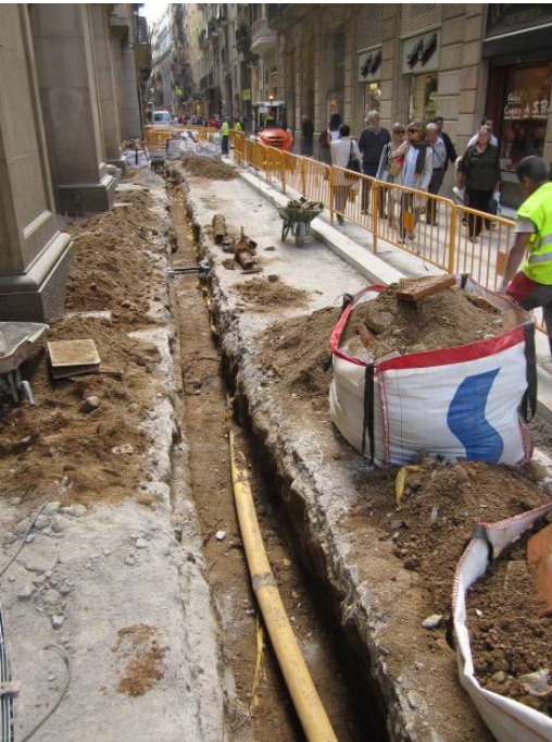
7. Imatge final de la rasa 1.
