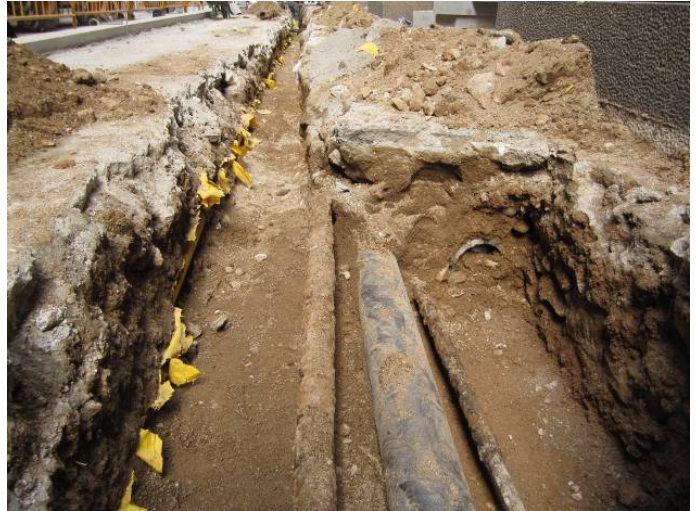
6. Detall de la rasa 1 un cop acabada.
