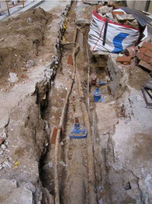
5. Vista general del procés d'excavació de la rasa 1.
