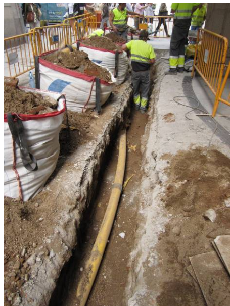
4. Vista general del tram final de la rasa de la rasa 1.
